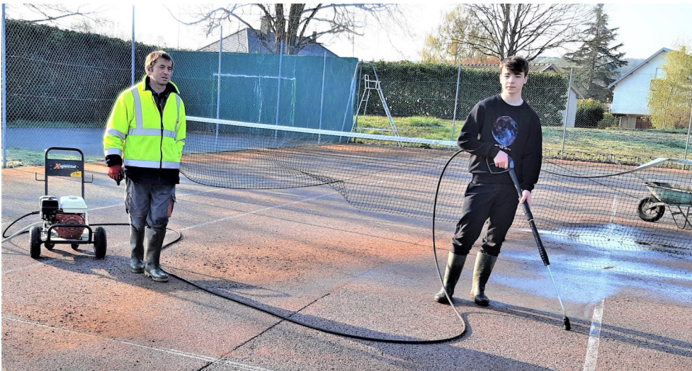
Guillaume passant le jet à haute pression sur le terrain de tennis.
